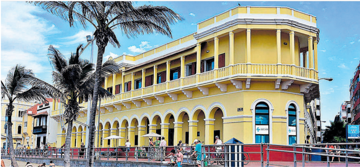
El Hospital San José (1981), pionero en el abordaje integral de la rehabilitación, realiza tratamientos de alta calidad y complejidad con excelentes resultados. | LP
